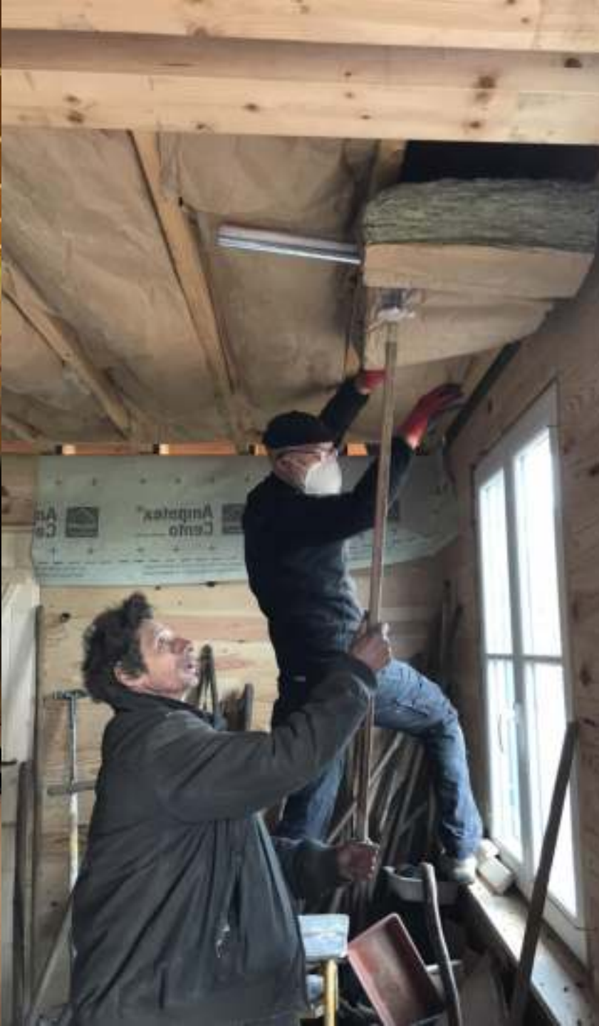
Isolation plafond d'atelier avec laine de roche de 15 ans
